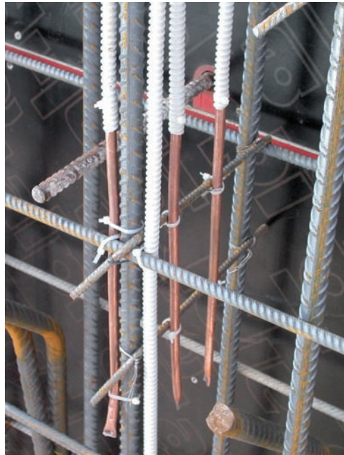
Fig. 8 - Particolare disposizione delle sonde e loro alloggi.
